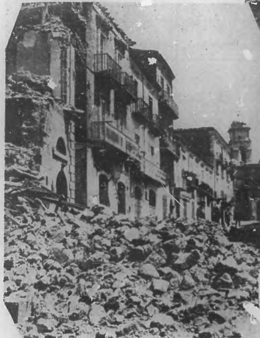
Estado en que quedó la calle principal de Amalfi (Italia), después de los temblores sísmicos que costaron la vida a más de tres mil personas
